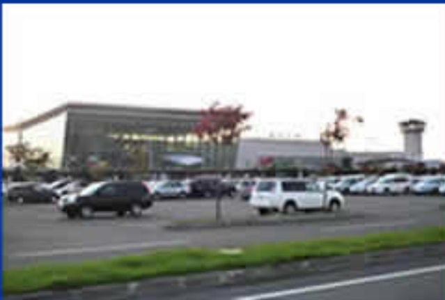
旭川空港ターミナル
